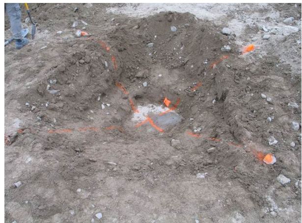
Figure 13. Excavation d'une fuite pour réparation
