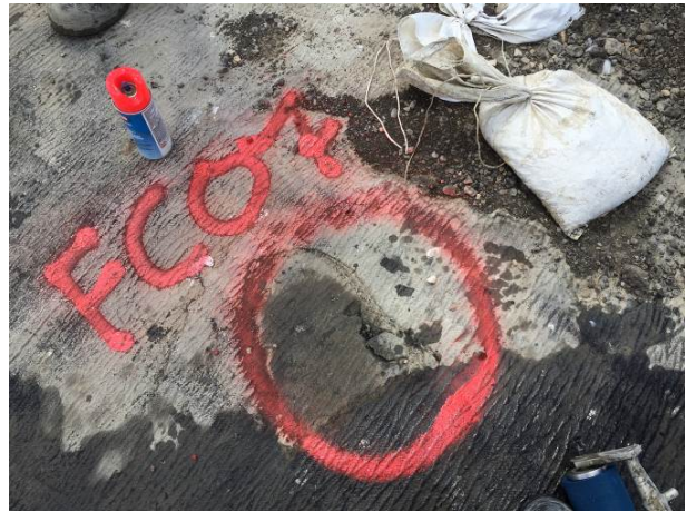
Figure 9. Marquage de peinture pour réparation
